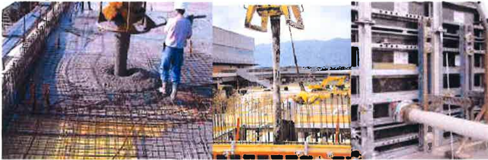
Betonieren mit SCC-Beton
